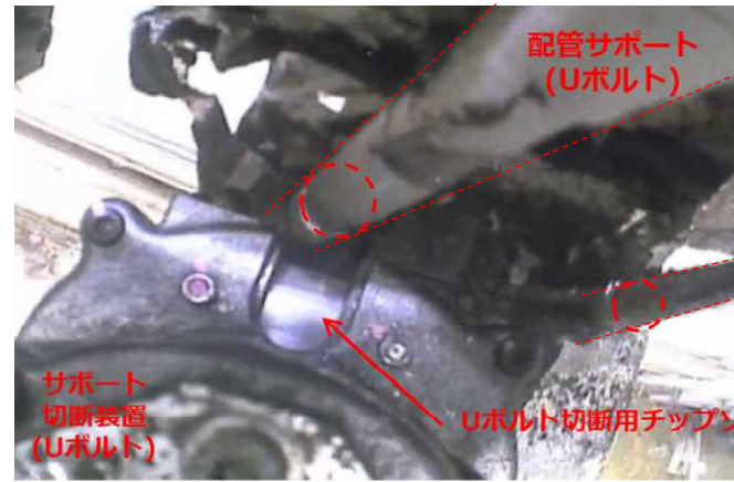
配管サポート切断
