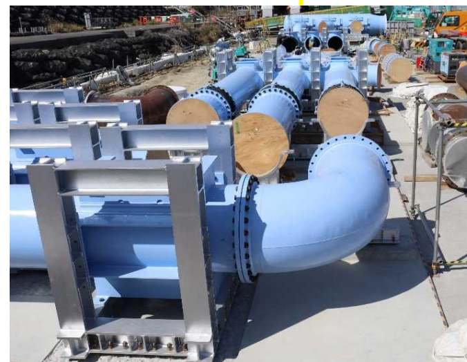
海水移送配管・海水配管ヘッダ設置の状況
