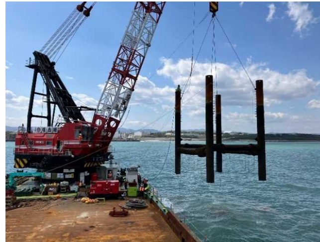
測量櫓（上段）撤去状況
