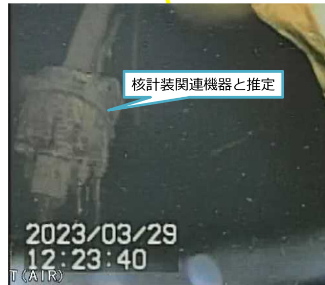
写真3. 核計装関連機器と思われる構造物 (気中監視カメラで気中を撮影)
