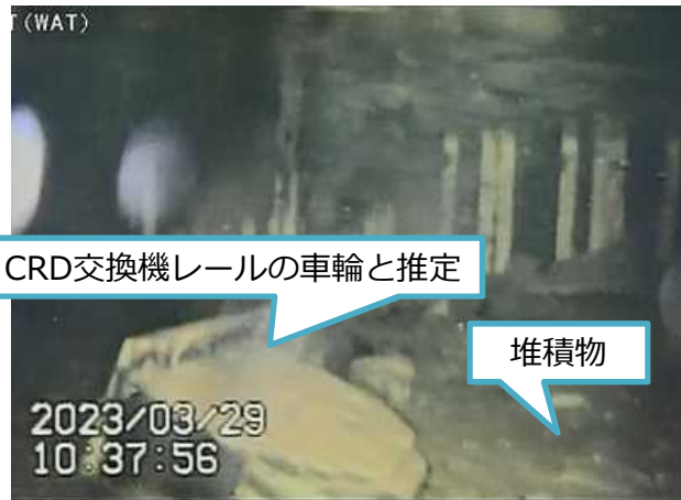
写真1.CRD交換機レールの車輪と思われる構造物
