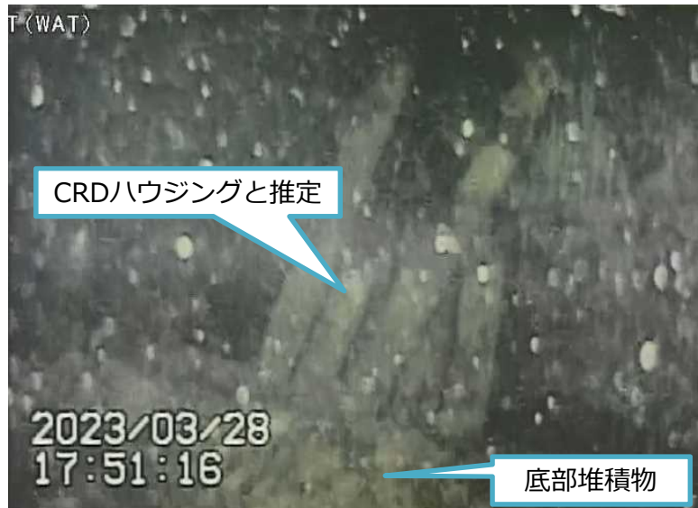
写真1. CRDハウジングと思われる構造物
