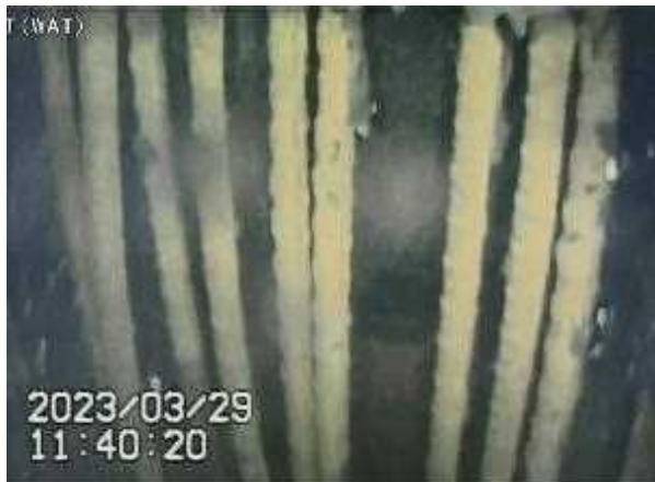
写真2. ポイント⑪下部
