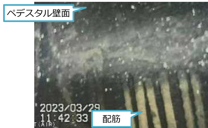
写真1. ポイント⑪ペDESTAL基礎部
