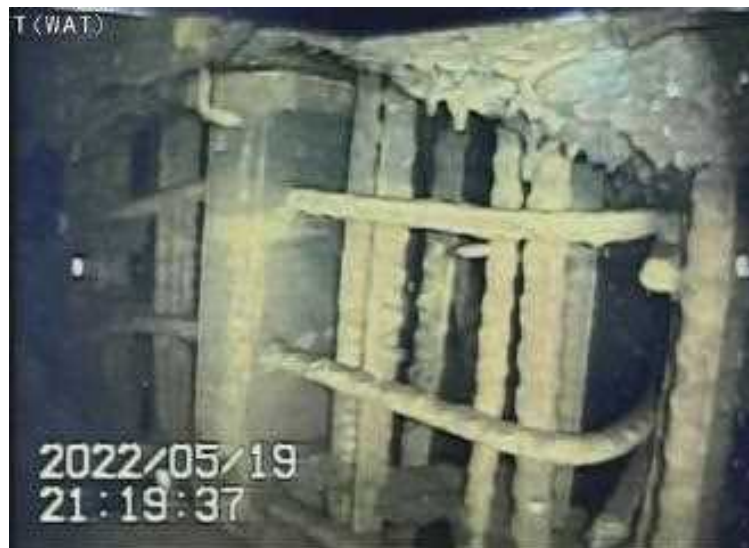
アクセス開口部付近 調査状況
