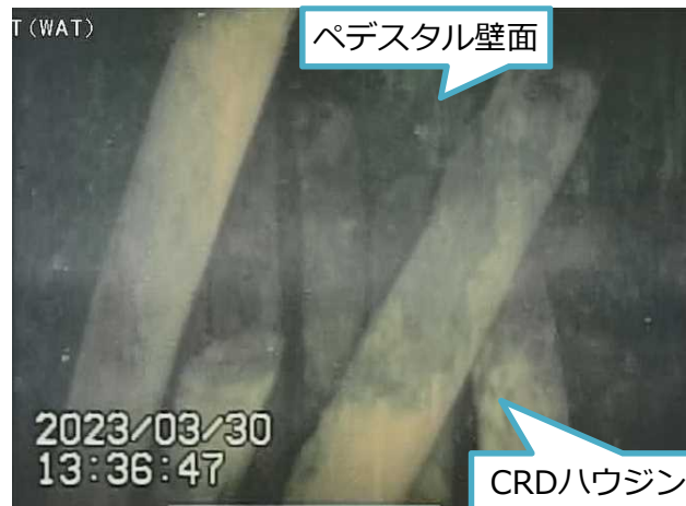
写真2. CRDハウジングと思われる構造物
