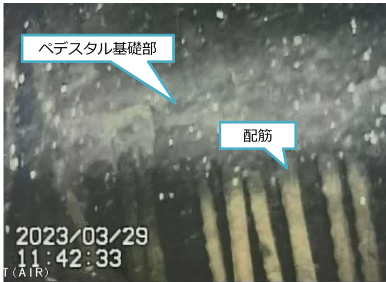
写真1.ペDESTAL内壁面部(上部)
