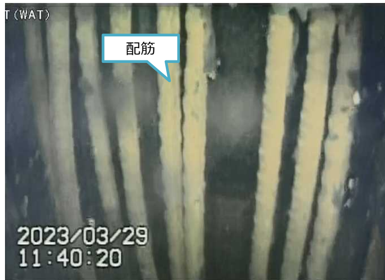
写真2.ペDESTAL内壁面部(下部)
