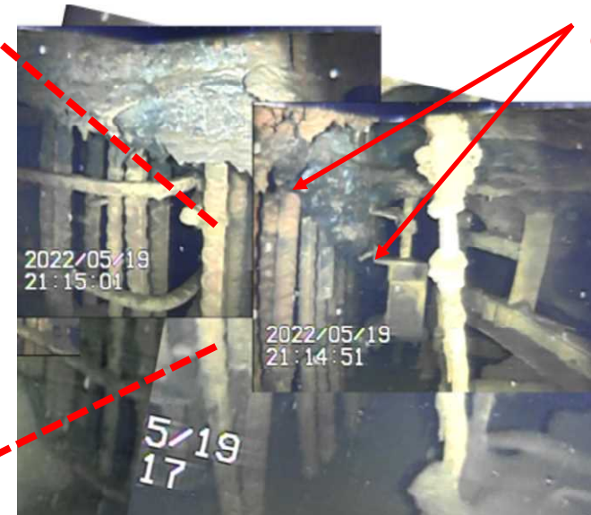
写真2. ペDESTAL外部から見えているコンクリート残存部
