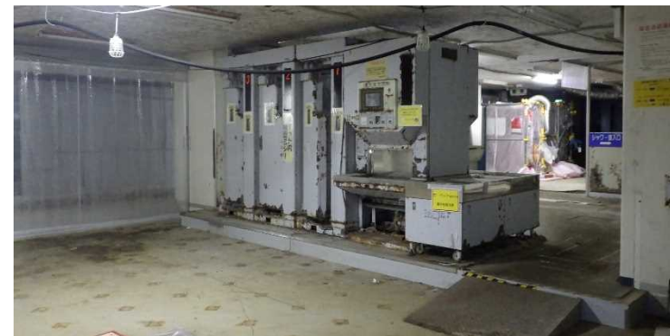
補機設置予定エリア付近
