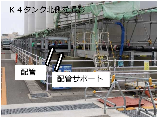
循環配管・サポート設置の状況
