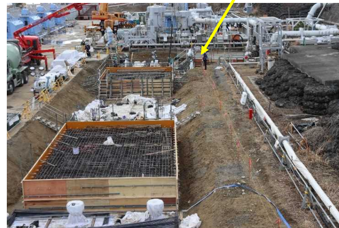
海水移送配管基礎の構築状況
