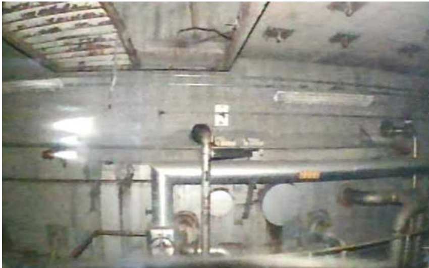
東側 T.P.+6m~T.P.+8m付近：多少のにじみ
