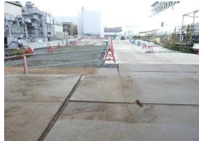
3号機側から4号機側を望む。(陸側遮水壁側から施工中)
