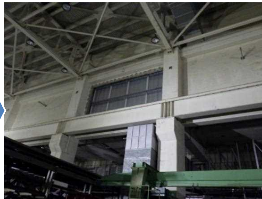
写真②：BOP損壊部分（塞ぎ後、屋内側）
