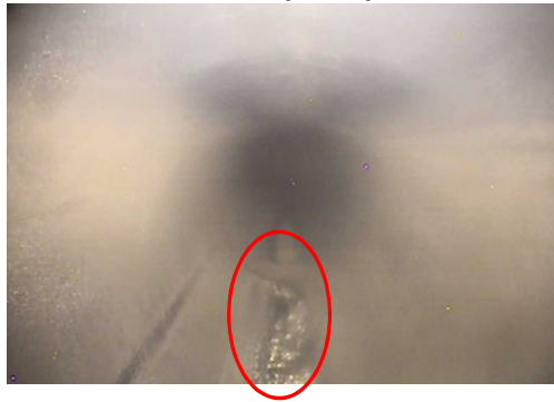
①RCW-Hx(A)(B)側の配管底部の堆積物
