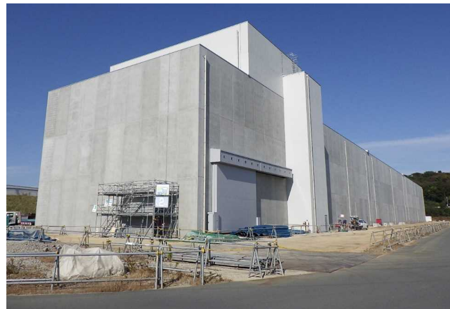
【現場状況：南面・東面】
