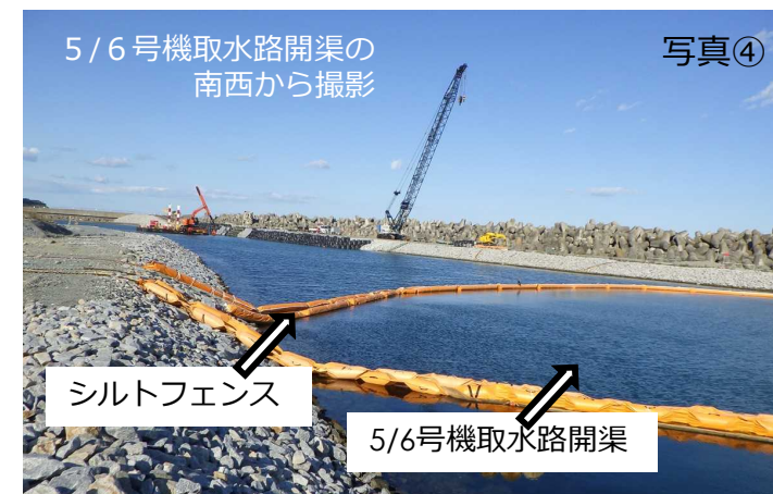
5・6号機海側工事エリアの状況
