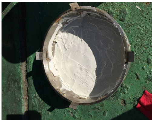
内面への接着剤塗布後
