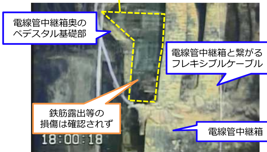
写真4. 中継箱奥ペDESTAL壁面(堆積物上部)
