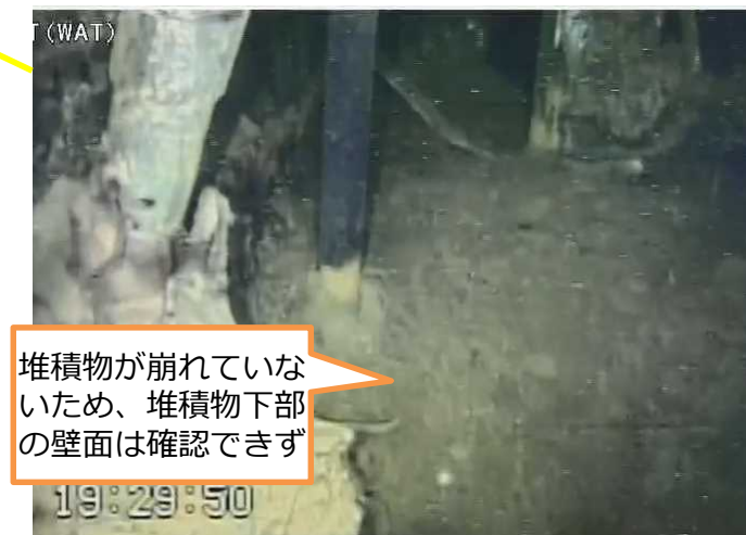
写真6. 遮へい板裏ペDESTAL壁面 (堆積物周辺)
