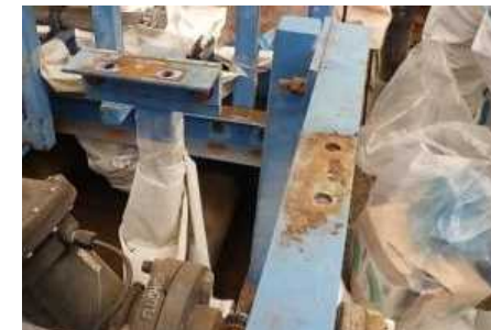
サポート部（配管取外後）
