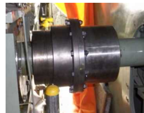
ギアカップリング交換後(塗装前)
