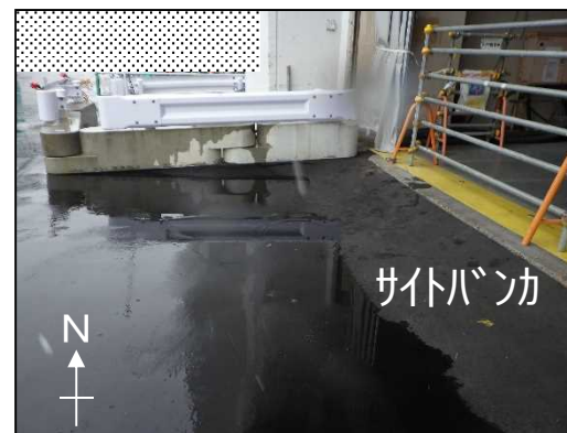
サイトバンク建屋大物搬入口状況
