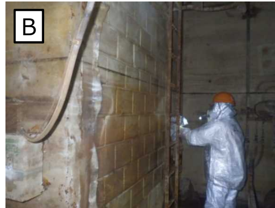
地下1階内壁面B
