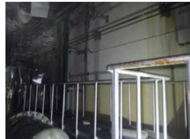
4階プール壁西面（写真）
