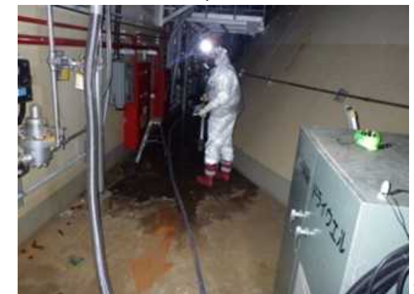
写真 d : 北東面
