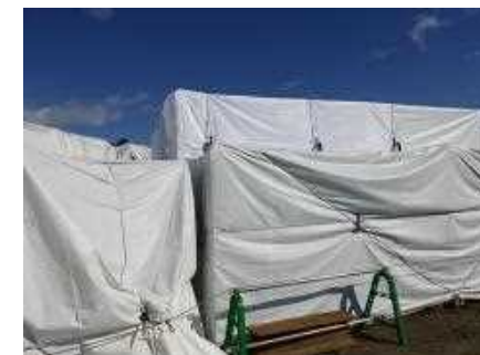
シート養生をして保管中
