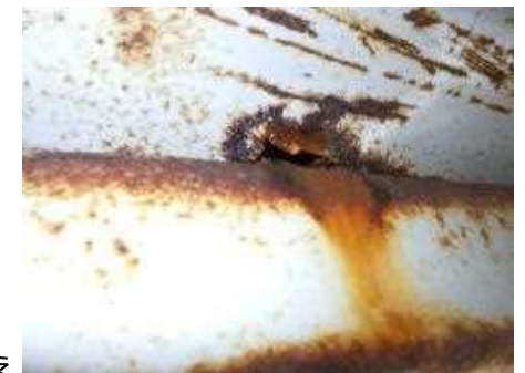
(例)著しい錆、腐食あり
