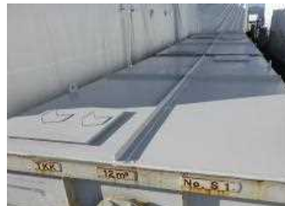
ノッチタンク塗装の状況
