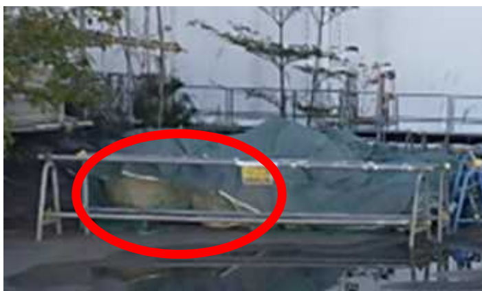
シート養生の不備
