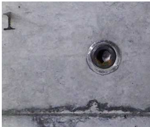
ベント孔 (開放前)
