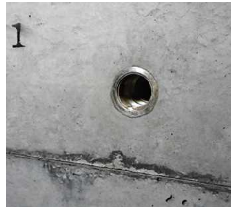
ベント孔 (開放後)
