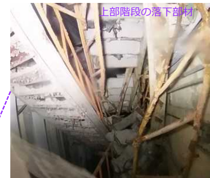
写真3A: 南東階段周辺
