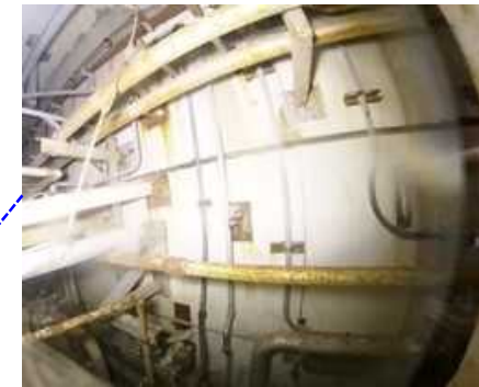
写真3D: プール壁西面
