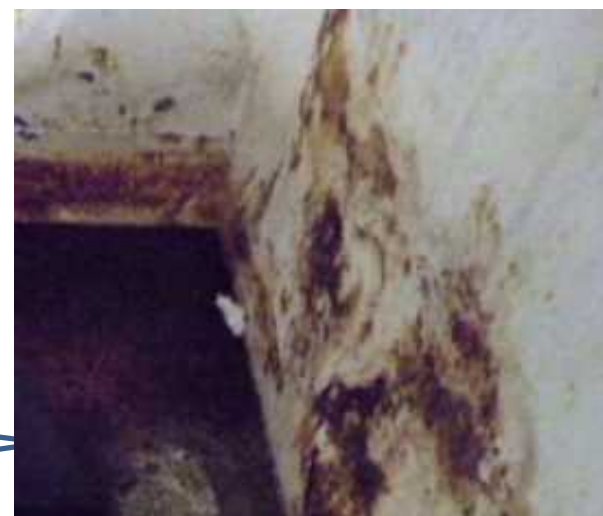
コンテナ内面・補修箇所の状況
