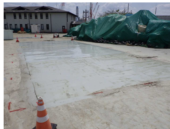
アスファルト再舗装(4月15日)・塗装(4月16,19日) 【4/20撮影】
