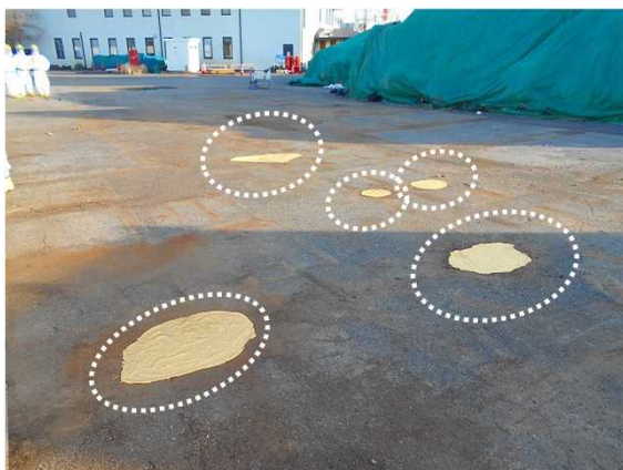
堆積物除去・除染材塗布後（3月24日）
