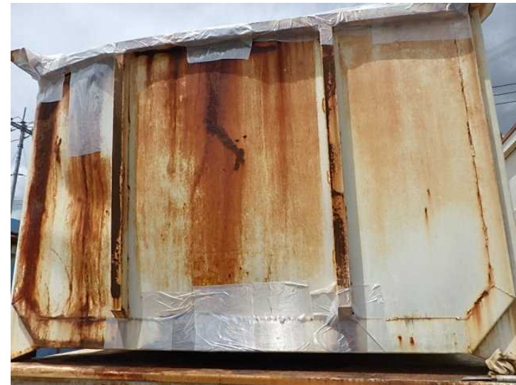
フィラメントテープによる養生後
