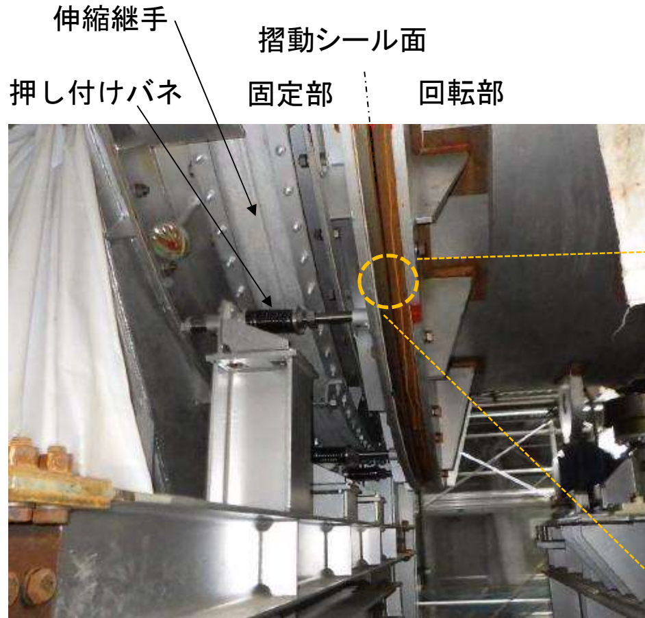
ロータリーキルン シール部(入口側)
