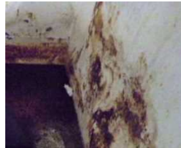
図16. 容器内面・補修箇所の状況
