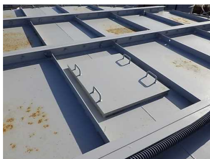
天板点検口（蓋あり）
