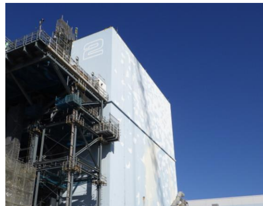
2号機原子炉建屋 点検写真例（南側）
