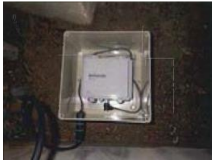
① 1階レベル (北西側構台下)
