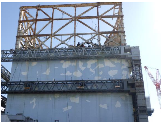
1号機原子炉建屋 点検写真例（北側）
