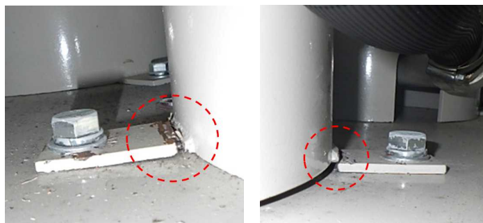
②損傷箇所（固定部割れ）
