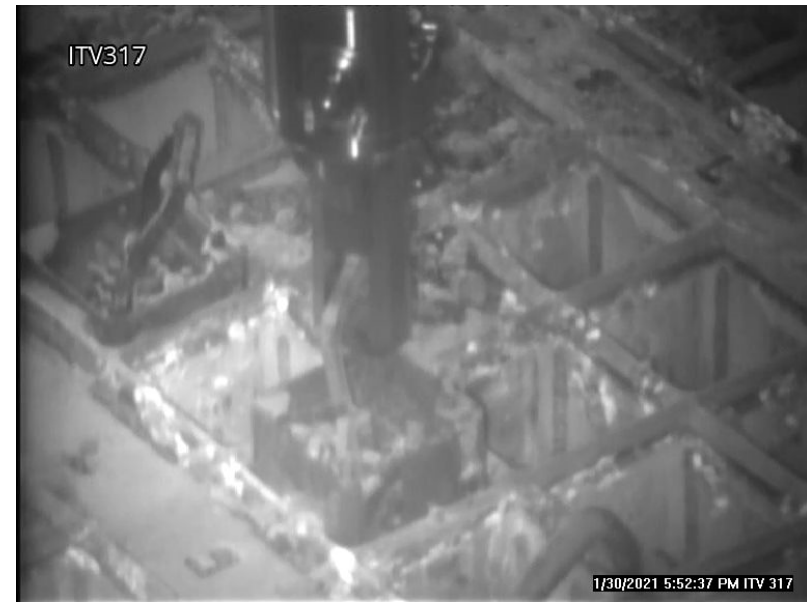
吊り上げ状況例 (⑩)
