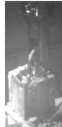
吊り上げ状況
