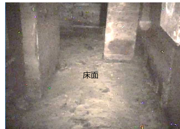
3号機タービン建屋 サービスエリア最下階床面
