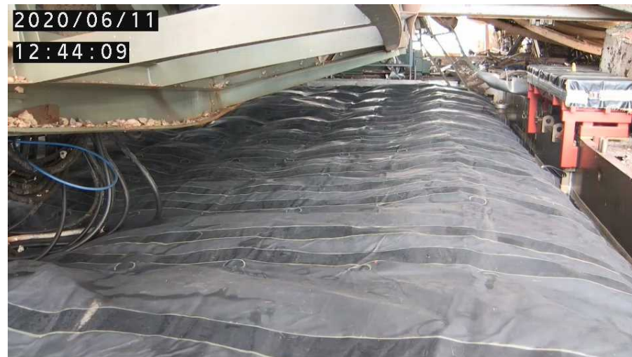
【養生バックへのエアモルタル充填が完了※】
