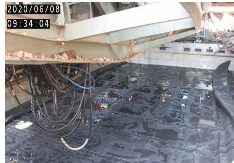
【SFP上で養生バック展張完了※】
