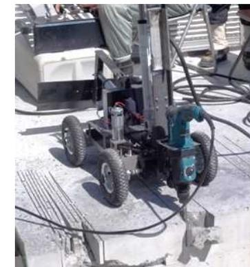
削りロボット(モックアップ機)
