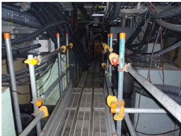
写真1：堰設置予定箇所
