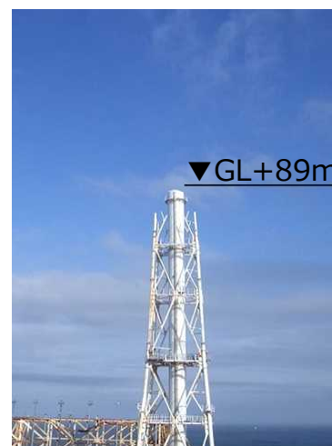
12ブロック解体後 (2020年3月9日)
