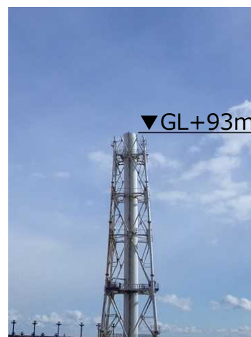
11ブロック解体後 (2020年2月4日)
