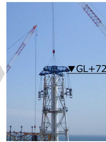
18ブロック解体後 (2020年4月8日)
