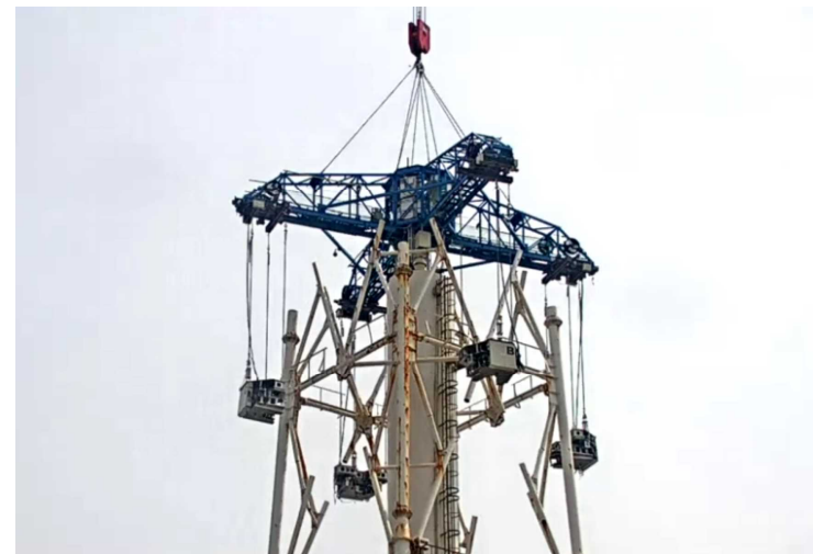
19ブロック目鉄塔解体作業状況(4月15日)
