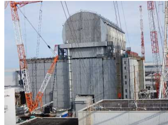
3号機原子炉建屋外観写真の例
