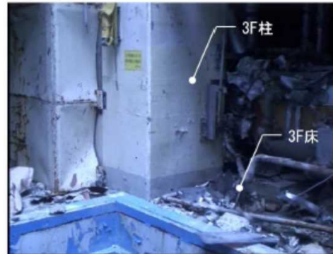
⑤3F床（大物搬入口東側）
