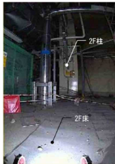
②2F床及び中間部の柱
