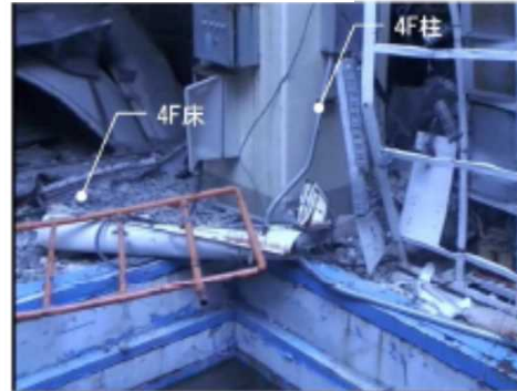
⑤4F床（大物搬入口東側）
