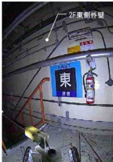
①2F階段口東側外壁
