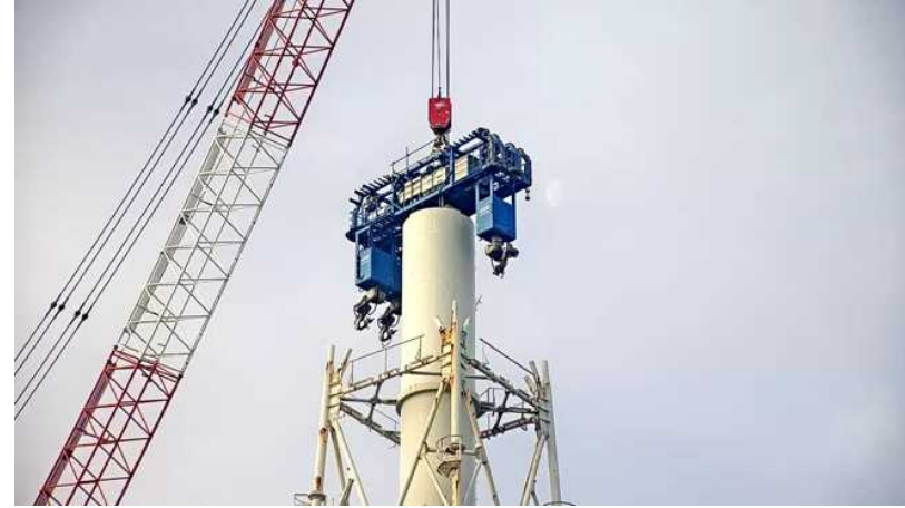
9ブロック目筒身解体作業(1月16日)
