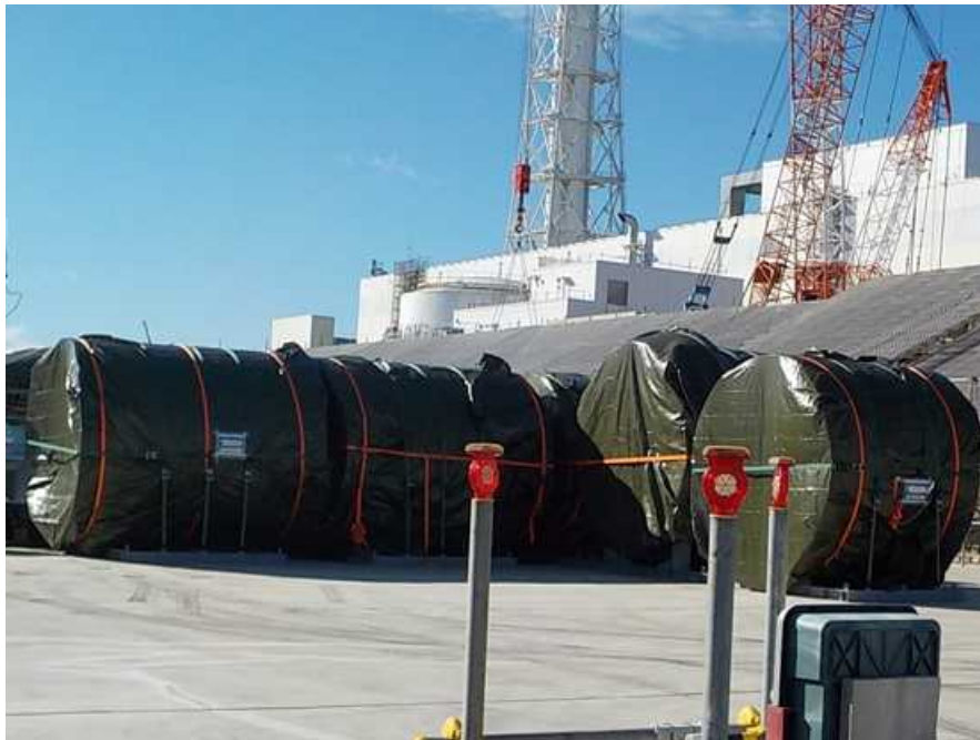
【写真①】筒身の仮置き状況 (仮置きヤード：2.5m盤)
