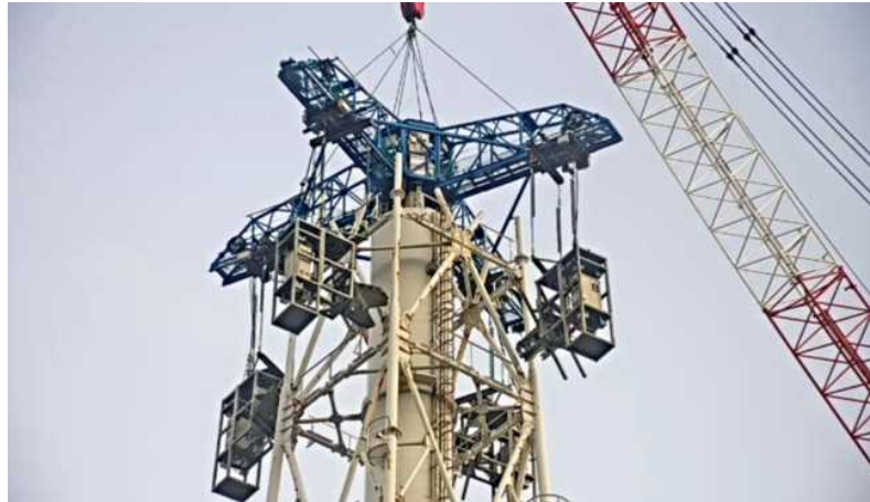
8ブロック目鉄塔解体作業(1月15日)
