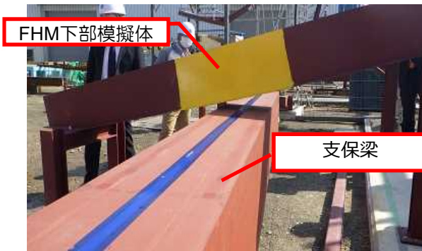
②支保梁挿入
