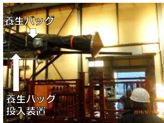
①養生バッグ投入
