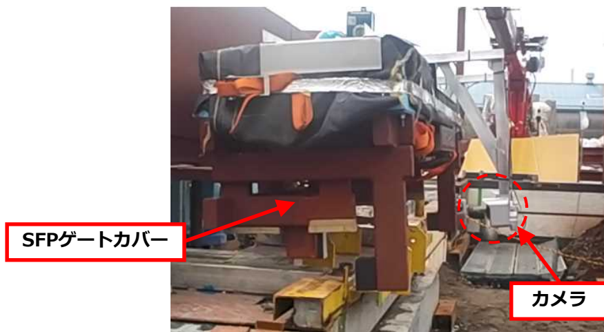
③：ゲートカバー設置（途中）
