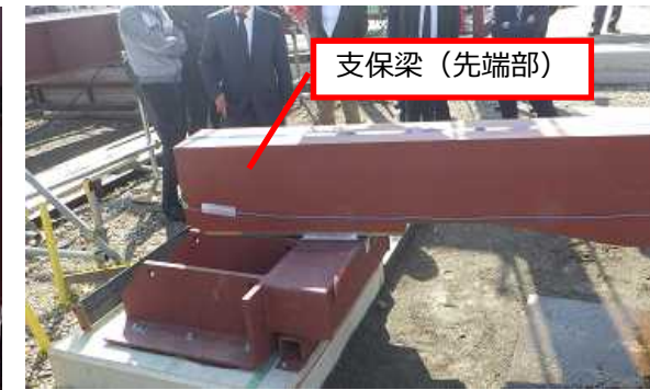
③支保梁挿入（完了）
