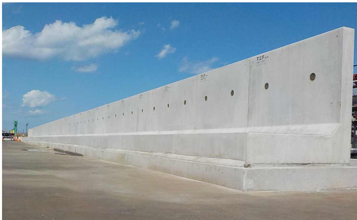
L型擁壁の据付状況（約100m）
