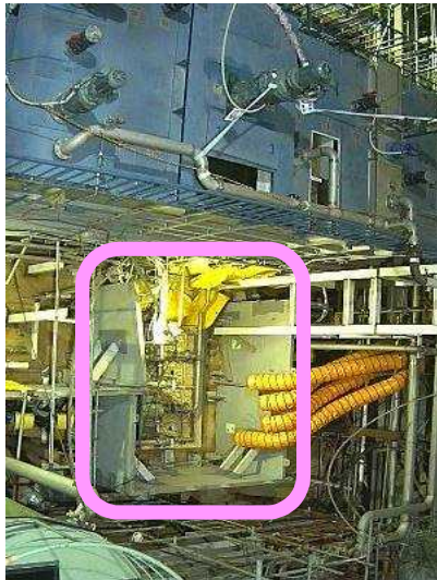
既設ポンプエリア (ホットスポット)
