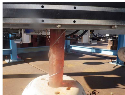
写真：落下防止ワイヤー
