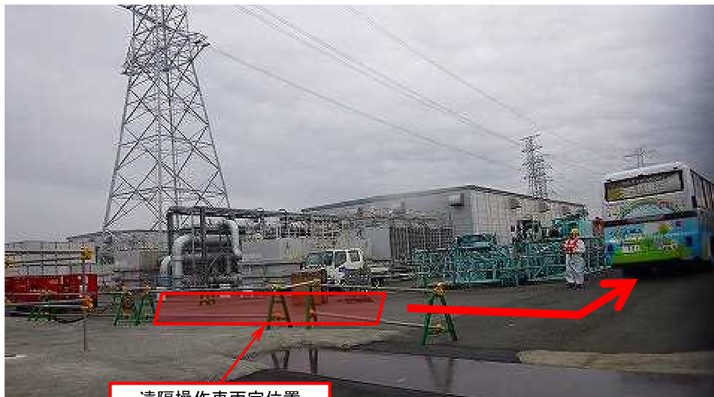
遠隔操作車両定位置
