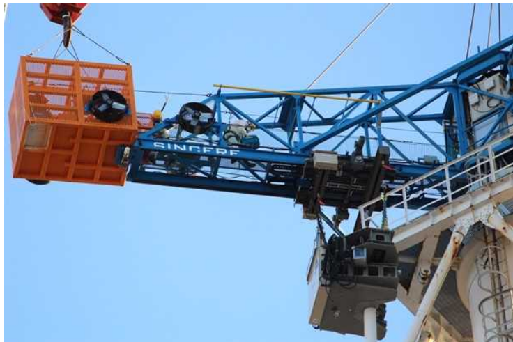
【写真⑤】 給油作業の状況(12月3日)
