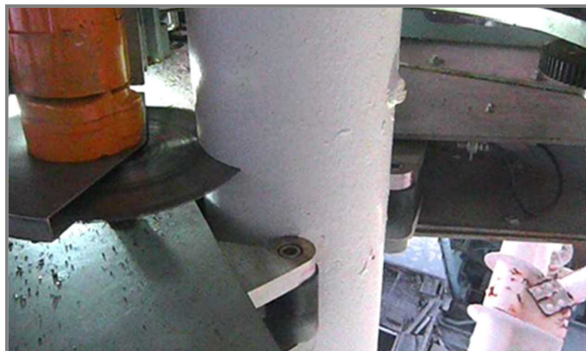
【写真③】斜材切断状況 (11月7日)
