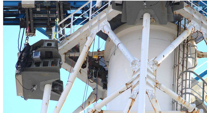
【写真⑥】 筒身切断状況 (12月4日)
