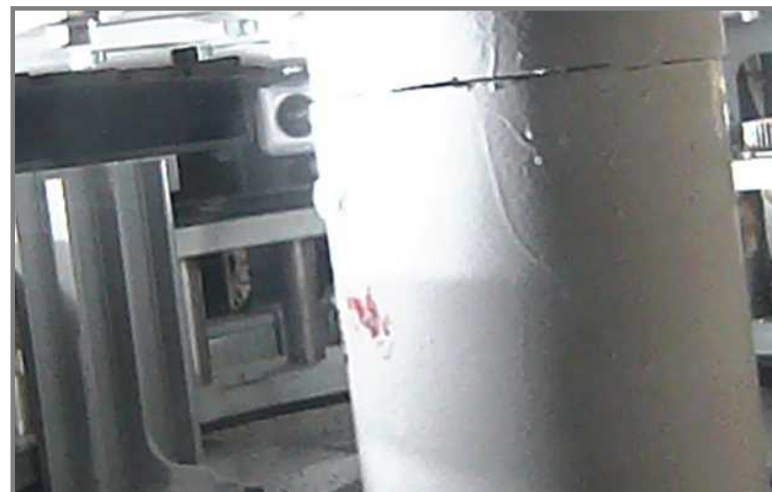
【写真④】主柱材切断状況(11月26日)
