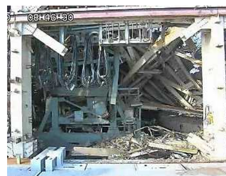
撤去後の東面2 (12月20日)
