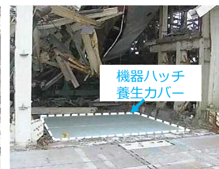
撤去後の西面、養生設置後 (3月6日)
