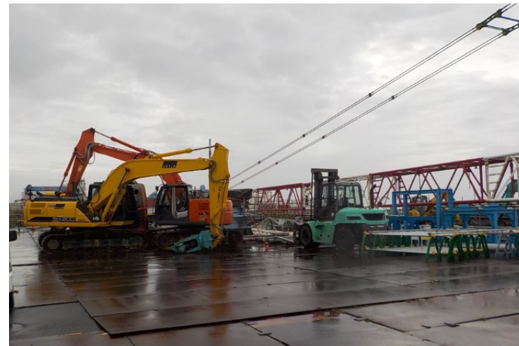
(350tクレーン)
