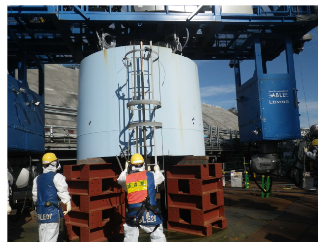
【写真④】吊り下ろし後 (9月26日)
