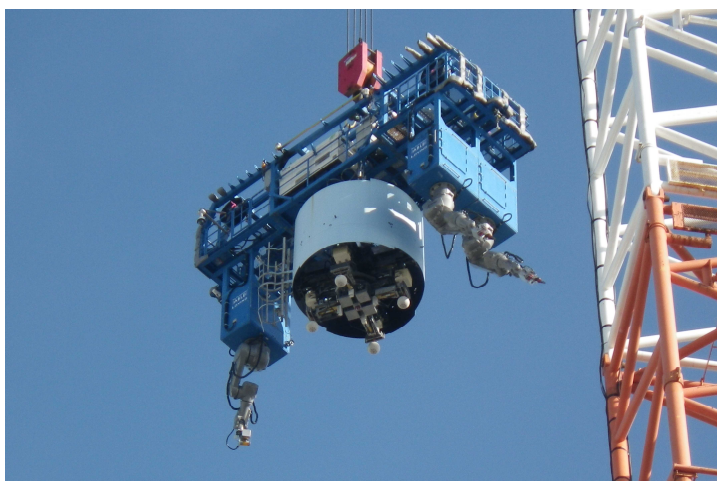
【写真③】吊り下ろし状況(9月26日)
