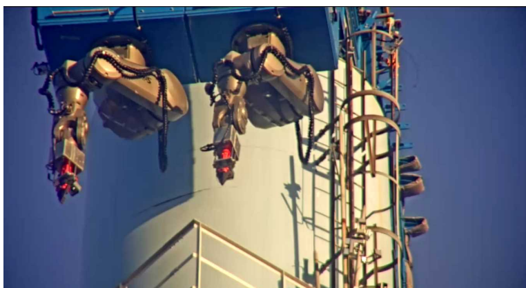
【写真①】筒身切断状況(9月18日)
