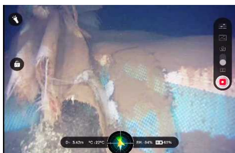
破損している土嚢
