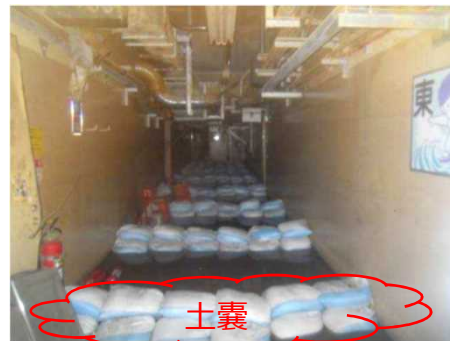
①PMBの土嚢設置時の状態
