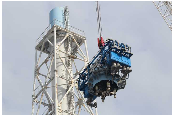
【写真⑦】 吊り下ろし状況(9月1日)
