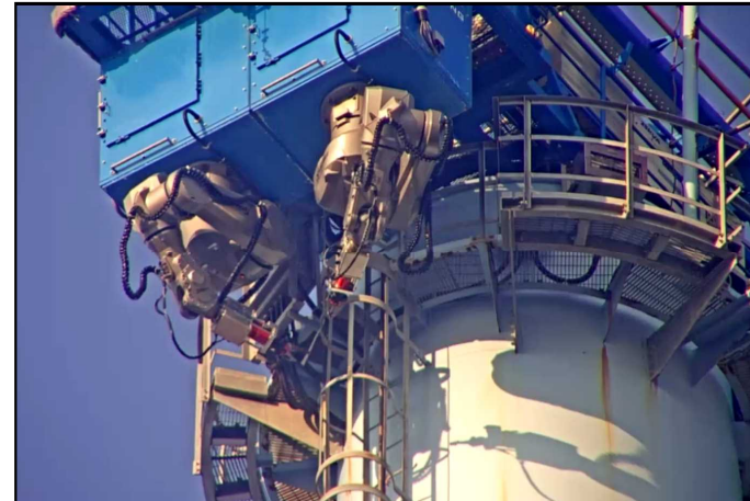
【写真②】 背カゴの切断作業写真 (8月1日)
