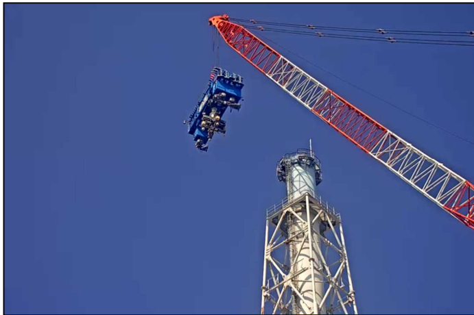
【写真①】 解体装置の設置状況 (8月1日)
