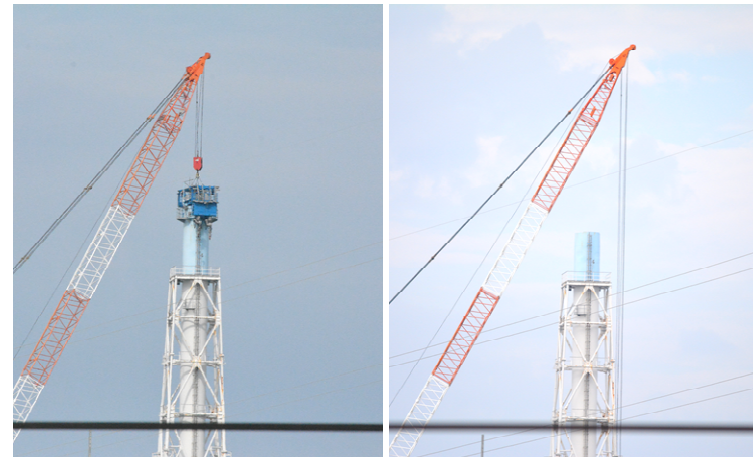
【写真⑧】 解体前後の比較 (9月1日)
