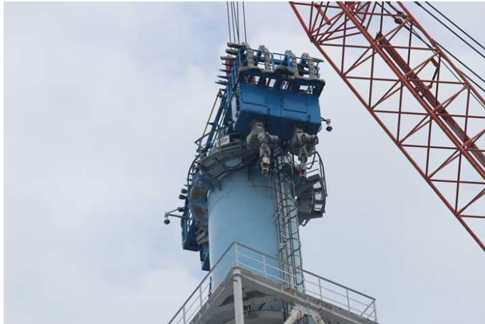
【写真⑤】 切断作業状況・外側(9月1日)
