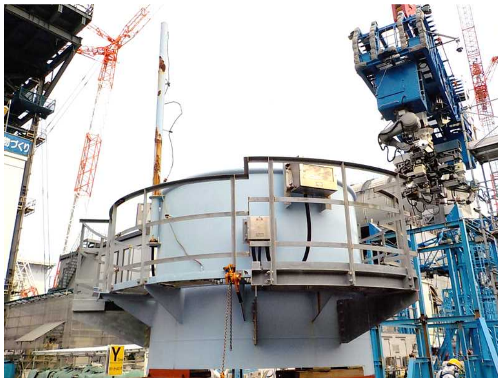
【写真⑨】 解体した部材
