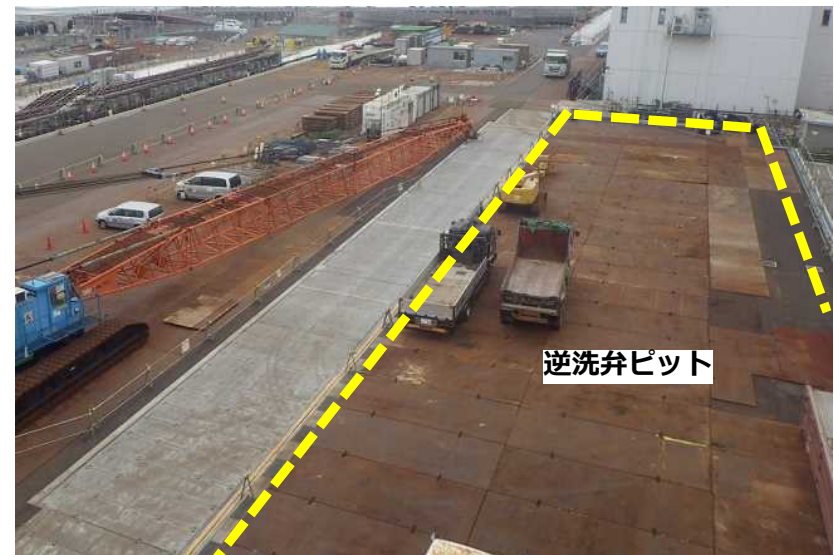
逆洗弁ピット覆工完了、鉄板敷き作業中
