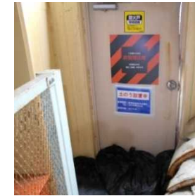
土のう設置例
