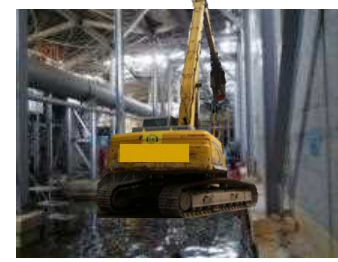
遠隔解体重機
