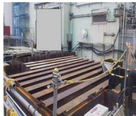
③ 補強鋼材設置
