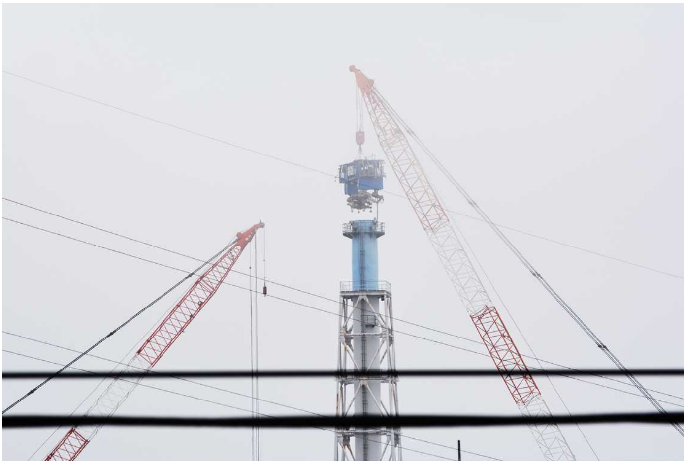
クレーン高さ確認の作業状況
