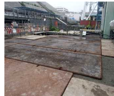
④ 敷鉄板設置
