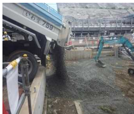
① 碎石敷き込み
