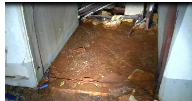
写真②：MSIV室入口の状況（2019.6.25）
