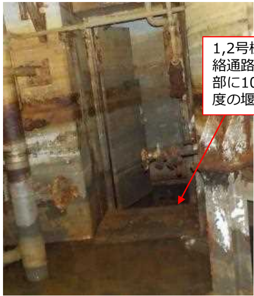
1,2号機Rw/Bの連絡通路の扉下の堰 (初回調査時)
