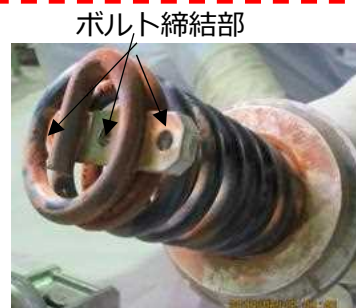
分離したガレキ撤去ツール (熊手) の下部
