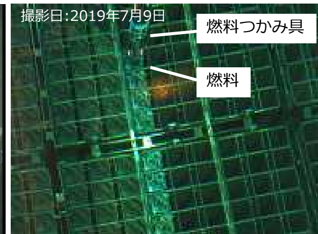
共用プールラックへ新燃料を収納
