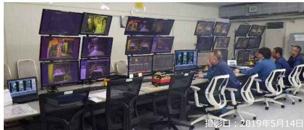
遠隔操作室の状況
