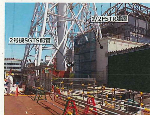
写真② クレーン設置予定場所の西側道路から排気筒方面を撮影 (SGTS配管がわずかに視認できるが霧困気線量は変わらない)
