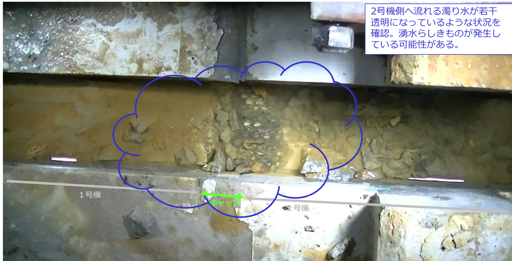
建屋間ギャップ（堰の貫通部）の拡大写真
