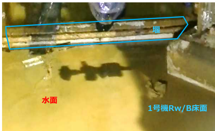
堰貫通前 (水がある状態)
