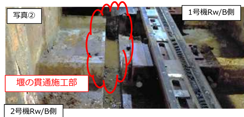
堰の貫通施工後の状況
