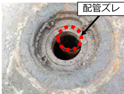
②ルーフドレン改修着手前
