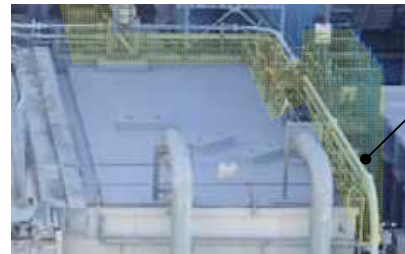
2号機FSTR建屋 対策後
