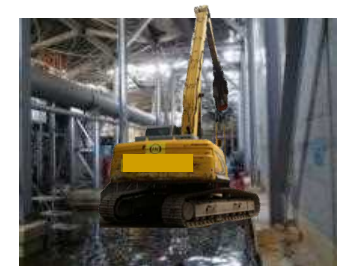
遠隔解体重機
