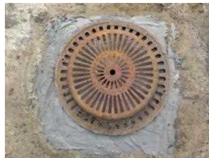
②ルーフドレン改修完了
