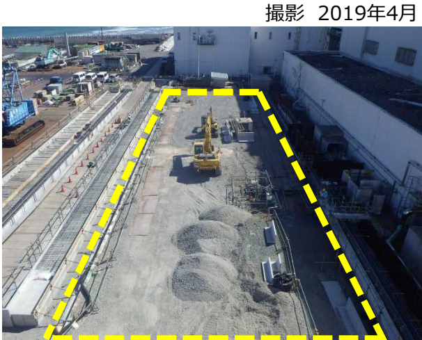
①クレーンヤード整備状況
