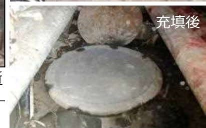
2号機取水電源ケーブルトレンチ貫通箇所 止水状況 (写真②), 充填状況 (写真③)
