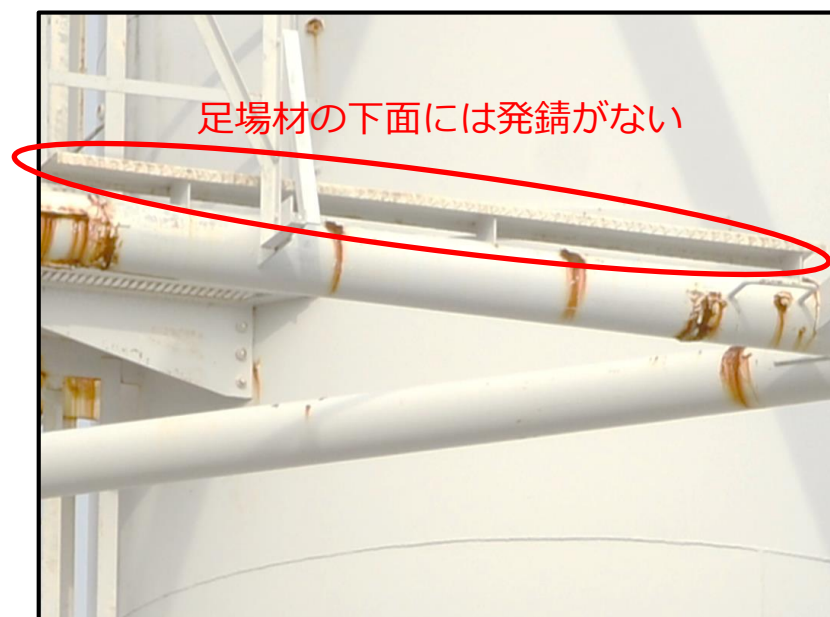
健全と推定される足場材
