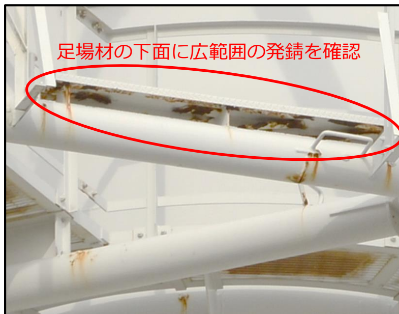
劣化進行が疑われる足場材
