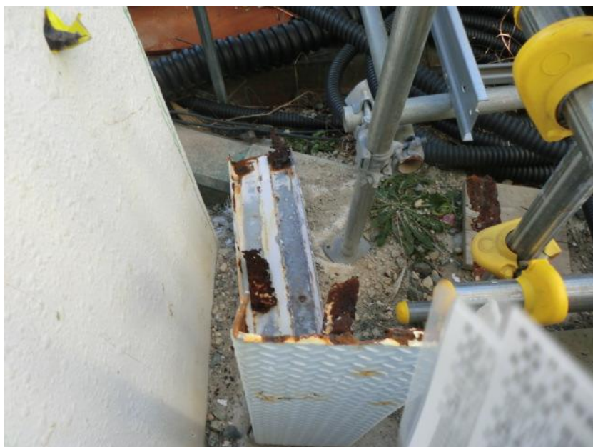
落下した足場
