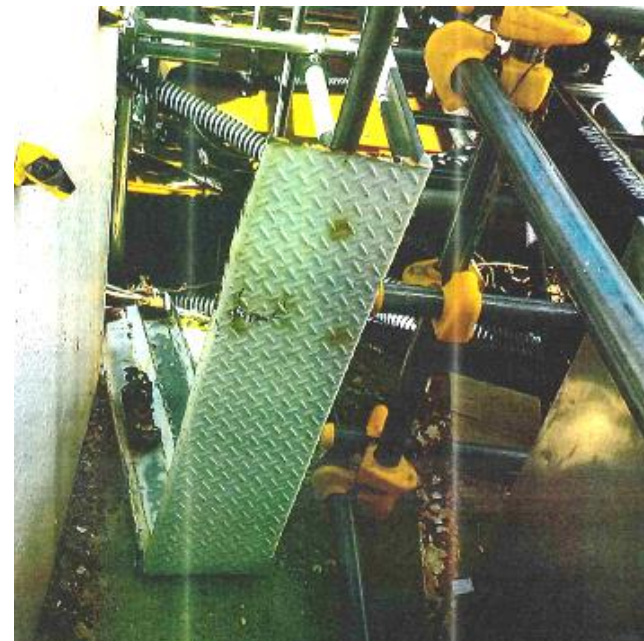
落下した点検用の足場
