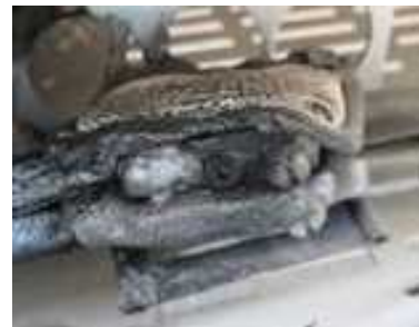
ブレーキレジスタ内の損傷
