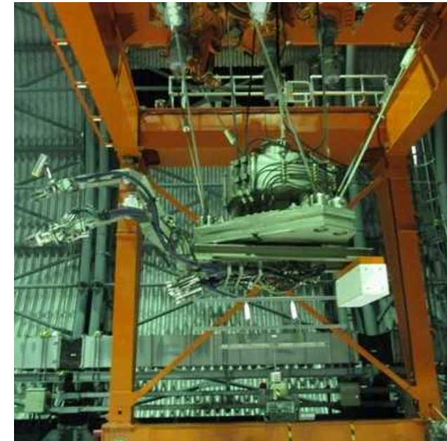
テンシルトラス吊り上げ状態
