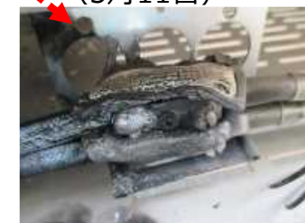
ブレーキレジスタ内の損傷 (5月12日)
