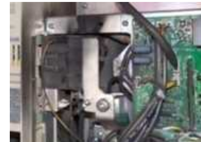
主巻インバータ内部の煤
