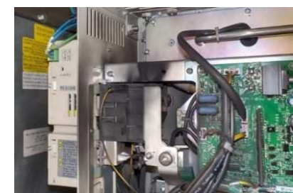
主巻インバータ内部の煤 (5月11日)
