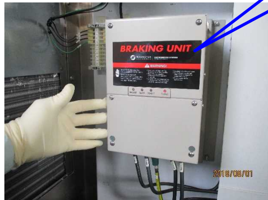
ブレーキユニットの外観 (交換後)
