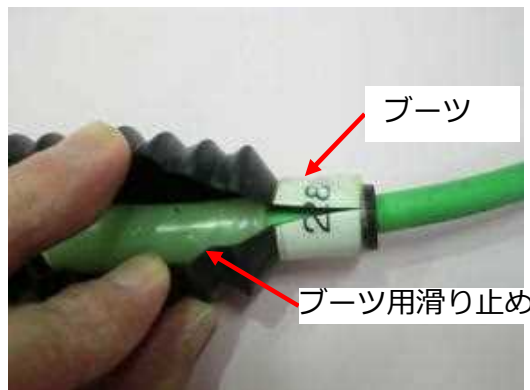
①ブーツ用滑り止めのずれ
