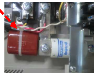
損傷の確認されたヒューズ (4月25日)
