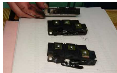
損傷の確認された整流器 (4月5日)
